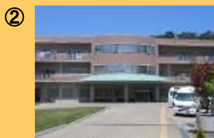
② 石部デイケア 介護老人保健施設石部ケアセンター 八起会ホームヘルプステーション
